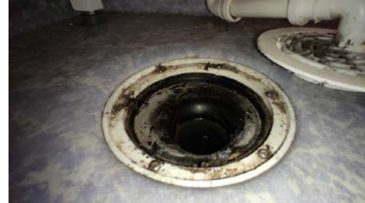
Kontroll av sluk.
