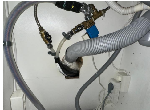
Rørapplegg i kjøkkenbenk med Waterguard
