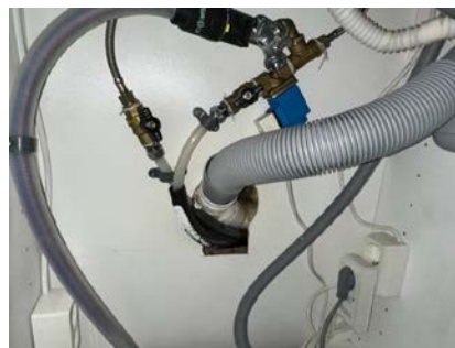
Rørpropp i kjøkkenbenk med Waterguard
