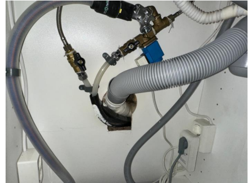
Røropplegg i kjøkkenbenk med Waterguard
