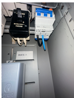
Sikringsskap med skru/ automatsikringer.
