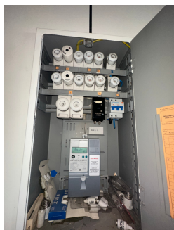
Sikringsskap med skru/ automatsikringer.
