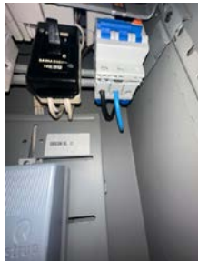
Sikringsskap med skru/ automatsikringer.
