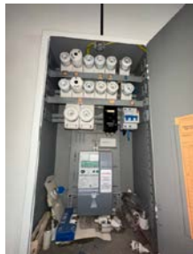
Sikringsskap med skru/ automatsikringer.
