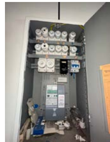
Sikringsskap med skru/ automatsikringer.
