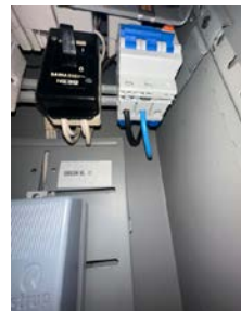
Sikringsskap med skru/ automatsikringer.
