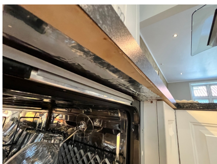
Noe fuktsvelling i underkant på benkeplate
