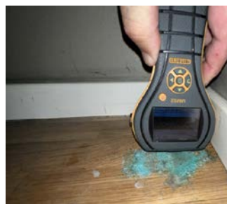
Merke på parkett under kjøleskap, ikke fukt.
