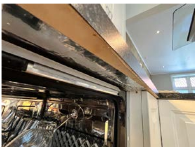
Noe fuktsvelling i underkant på benkeplate
