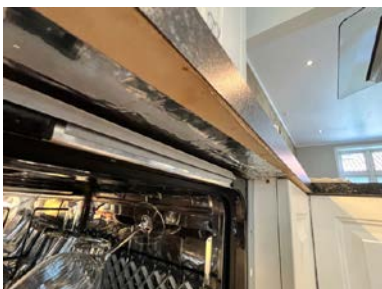
Noe fuktsvelling i underkant på benkeplate
