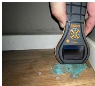
Merke på parkett under kjøleskap, ikke fukt.
