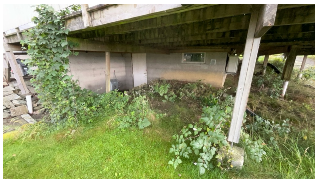
Kontroll av fundament.
