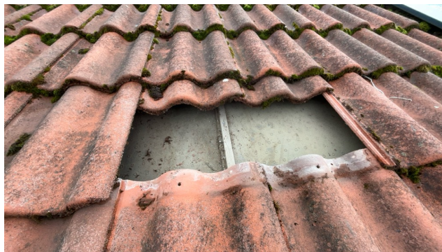
Kontroll av undertak.
