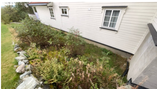
Kontroll av drenering/fuktsikring.
