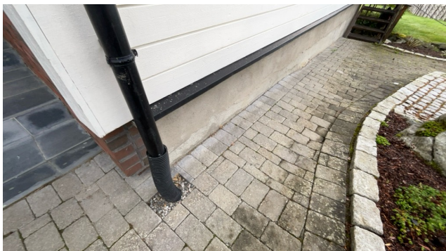
Kontroll av drenering/fuktsikring.
