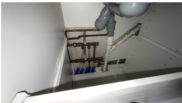
Besiktigelse av røropplegg.
