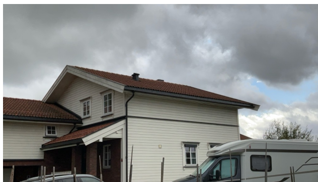
Besiktigelse av taktekke.
