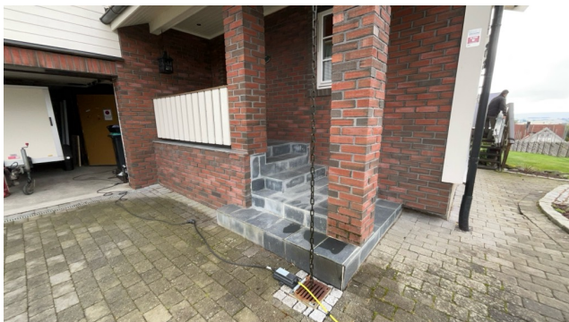
Besiktigelse av trapp.
