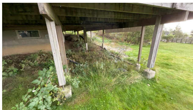
Kontroll av fundament.
