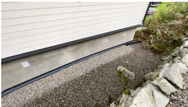
Kontroll av drenering/fuktsikring.
