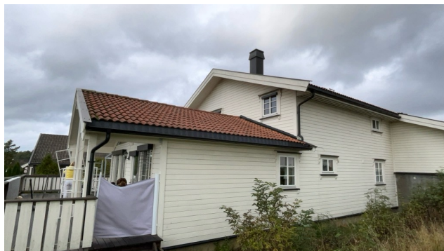
Besiktigelse av taktekke.
