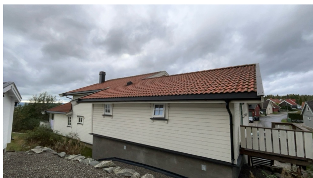
Besiktigelse av taktekke.
