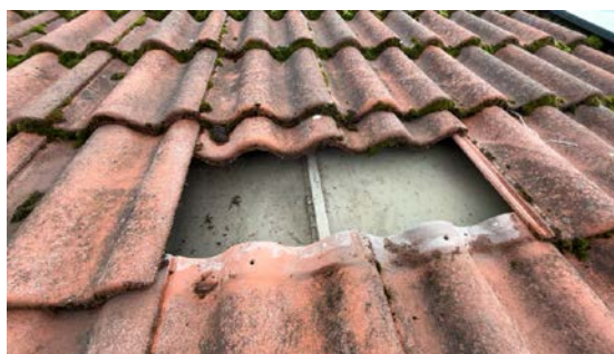
Kontroll av undertak.
