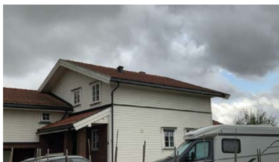
Besiktigelse av taktekke.
