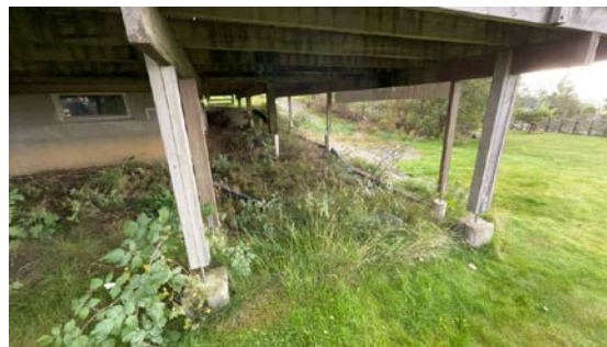
Kontroll av fundament.
