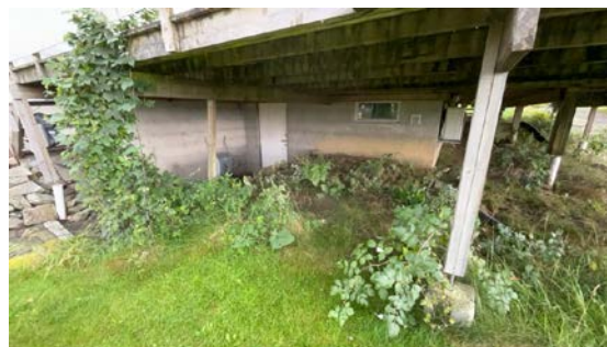
Kontroll av fundament.
