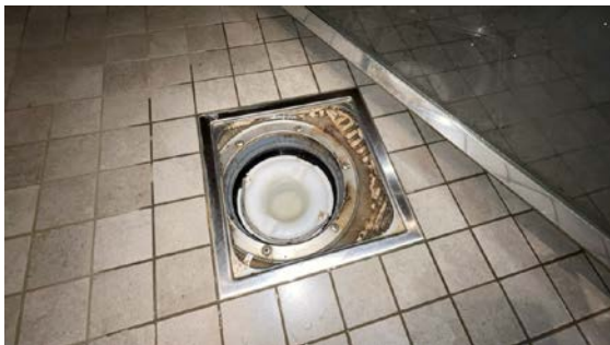
Kontroll av sluk.
