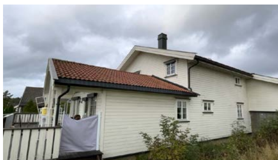
Besiktigelse av taktekke.
