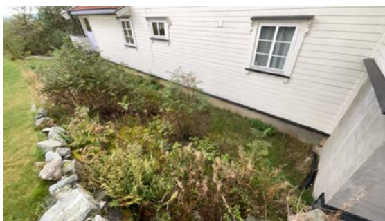
Kontroll av drenering/fuktsikring.
