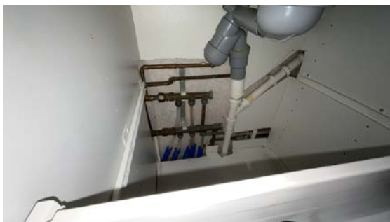
Besiktigelse av røropplegg.
