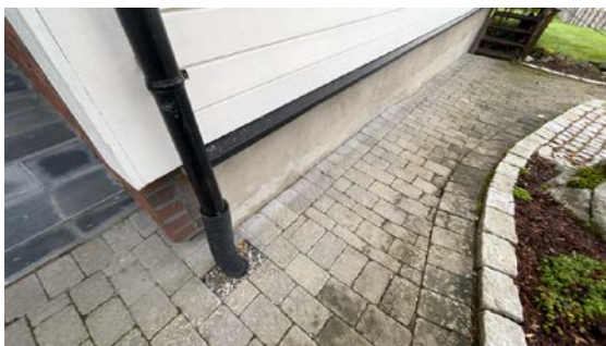
Kontroll av drenering/fuktsikring.
