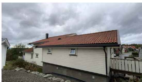
Besiktigelse av taktekke.
