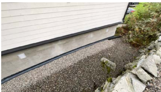
Kontroll av drenering/fuktsikring.
