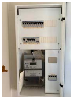
Bildet viser en åpen gjennomføring i sikringsskapet.
