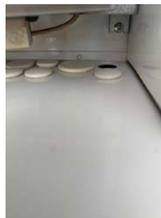
Bildet viser en åpen gjennomføring i sikringsskapet.
