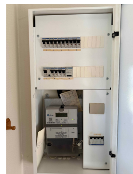
Bildet viser en åpen gjennomføring i sikringsskapet.
