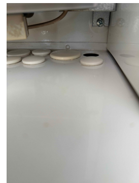
Bildet viser en åpen gjennomføring i sikringsskapet.
