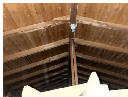
Oversiktsbilde fra loft.
