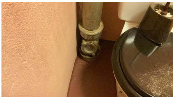
Stakepunkt på toalettrom i kjeller.
