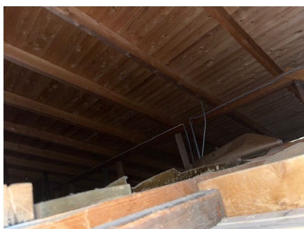
Oversiktsbilde fra loft.
