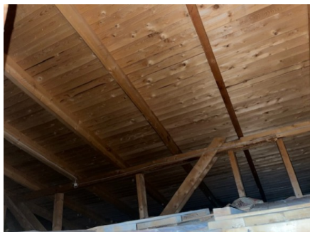
Oversiktsbilde fra loft
