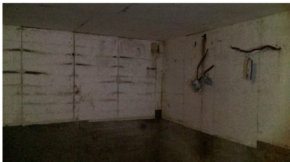
Enklere kjeller under veranda.
