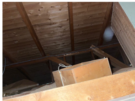
Oversiktsbilde fra loft.
