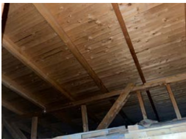
Oversiktsbilde fra loft
