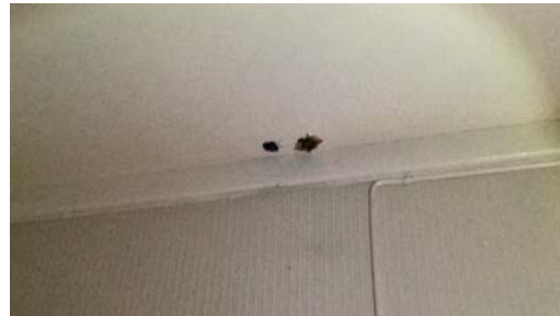
Eksempel på gjennomføring i himling.
