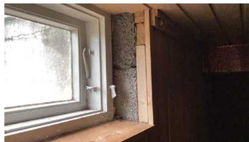
Grunnmur ser ut til å være av lettlinker.
