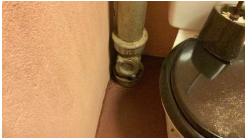
Stakepunkt på toalettrom i kjeller.
