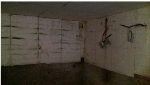
Enklere kjeller under veranda.
