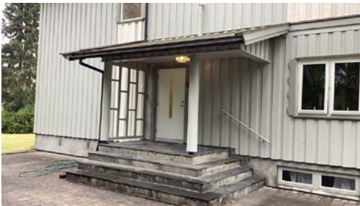
Trapp ved entre.
