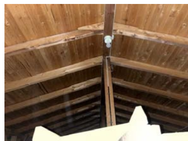
Oversiktsbilde fra loft.
