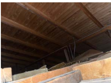
Oversiktsbilde fra loft.
