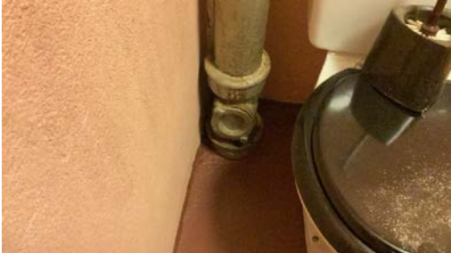
Stakepunkt på toalettrom i kjeller.
