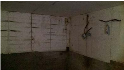
Enklere kjeller under veranda.
