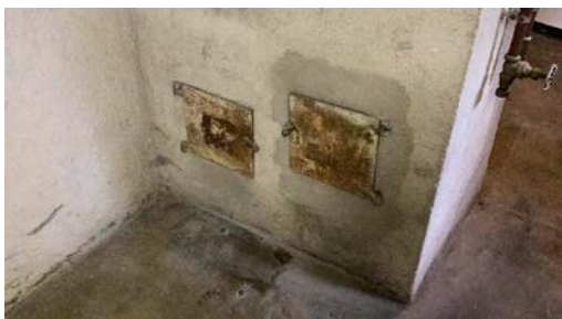
Sotluke i kjeller.
