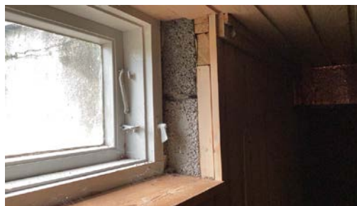
Grunnmurer ser ut til å være av lettklinker.
