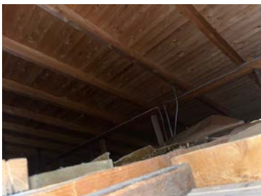
Oversiktsbilde fra loft.
