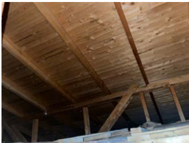
Oversiktsbilde fra loft
