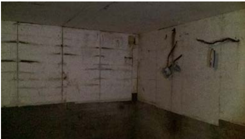
Enklere kjeller under veranda.
