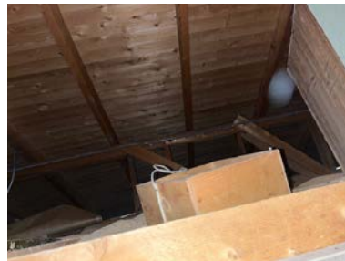
Oversiktsbilde fra loft.
