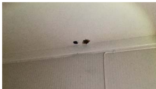
Eksempel på gjennomføring i himling.
