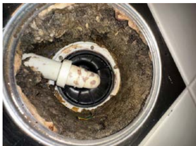
Plastsluk med klemring for membran
