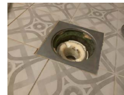
Sluk med synlig membran.
