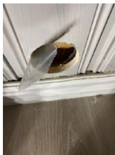
Plast i vegg.(stue mot bad i 1. etg)
