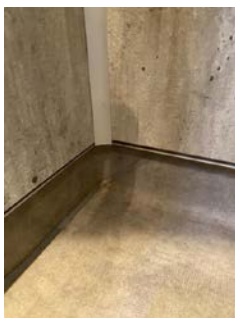
Fuger mangler i nedkant av plater.
