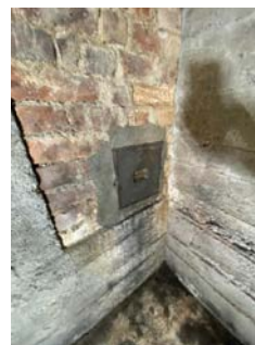
Pipa har rennemerker etter sotvann. Det er påvist sprekker og riss i pipe på kaldloft.
