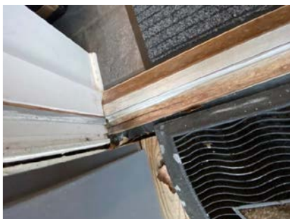
Terskel har sprekke, pakning i karm mangler delvis.
