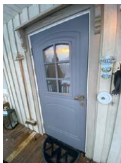
Terskel har sprekke, pakning i karm mangler delvis.
