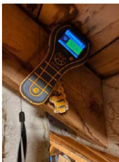
Fuktmåling i takkonstruksjon viste ingen forhøyede fuktverdier.
