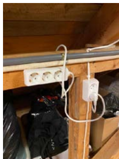
Ledinger under el-skap er ikke tilstrekkelig festet.
