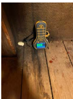
Fuktmåling mot råteskade materiale mot øst. Ingen forhøyede verdier.
