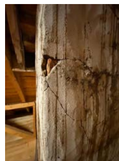
Pipa har rennemerker etter sotvann. Det er påvist sprekker og riss i pipe på kaldloft.
