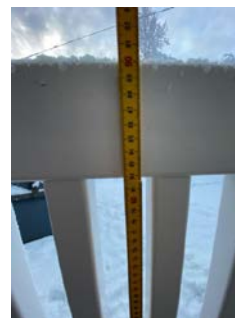
Rekkverket er for lavt i forhold til dagens krav til rekkverkshøyder. Høyde er målt til 90 cm.
