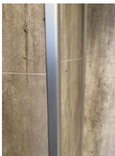
Fuger mangler i nedkant av plater.
