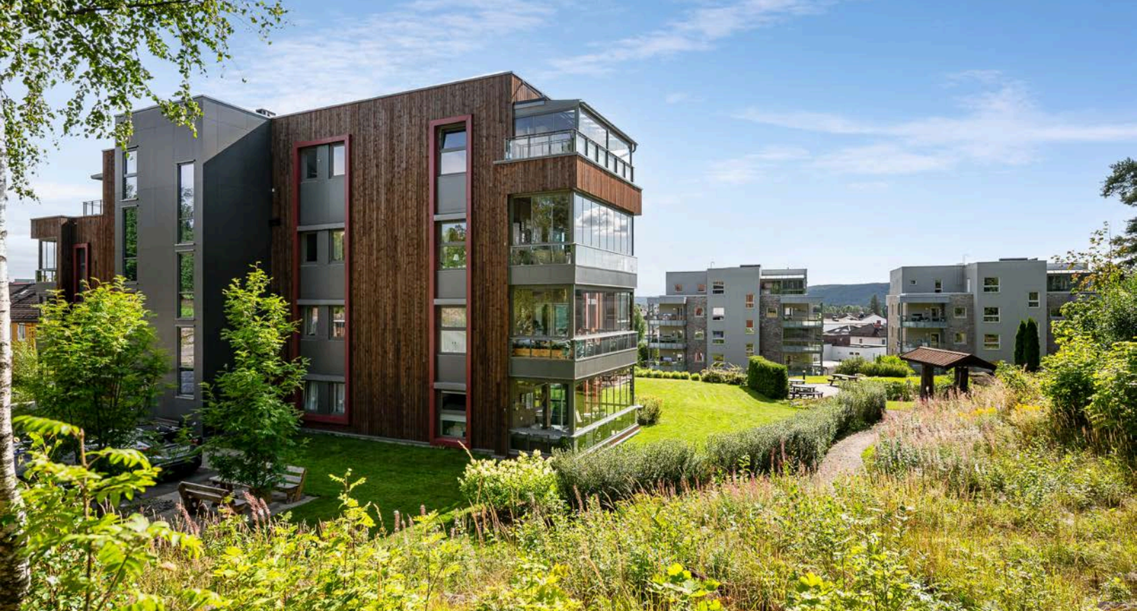
En stor, lys og attraktiv 3-roms selveiet hjørneleilighet i et nyere og moderne bygg fra 2018.
