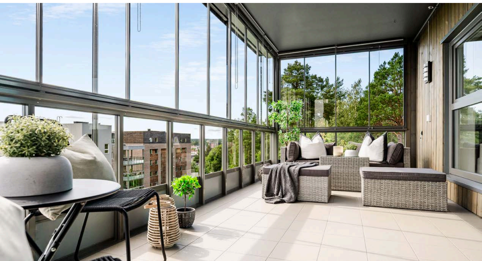
Balkongen har flislagt gulv, rekkverk med glassfelt og store vindusfelt med skyvefunksjon som kan åpnes opp. Det er også montert lys og strøm, samt innvendig og utvendig solskjerming.
