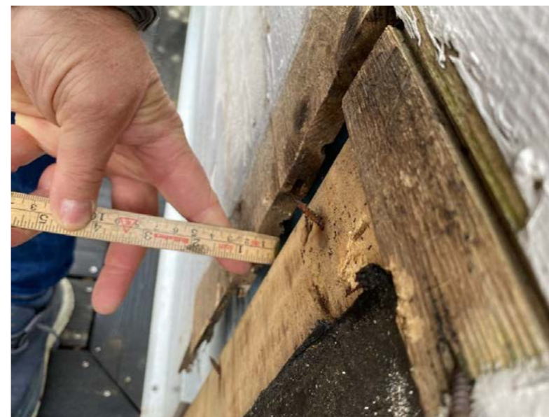
Bilde 3 Vider benyttet kledning med 13mm panel med not og fjær.
