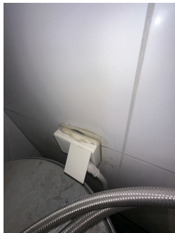
Varmtvannsbereder koblet til stikkontakt
