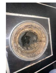
Sluk i plast, plassert i dusjnisje
