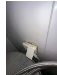
Varmtvannsbereder koblet til stikkontakt
