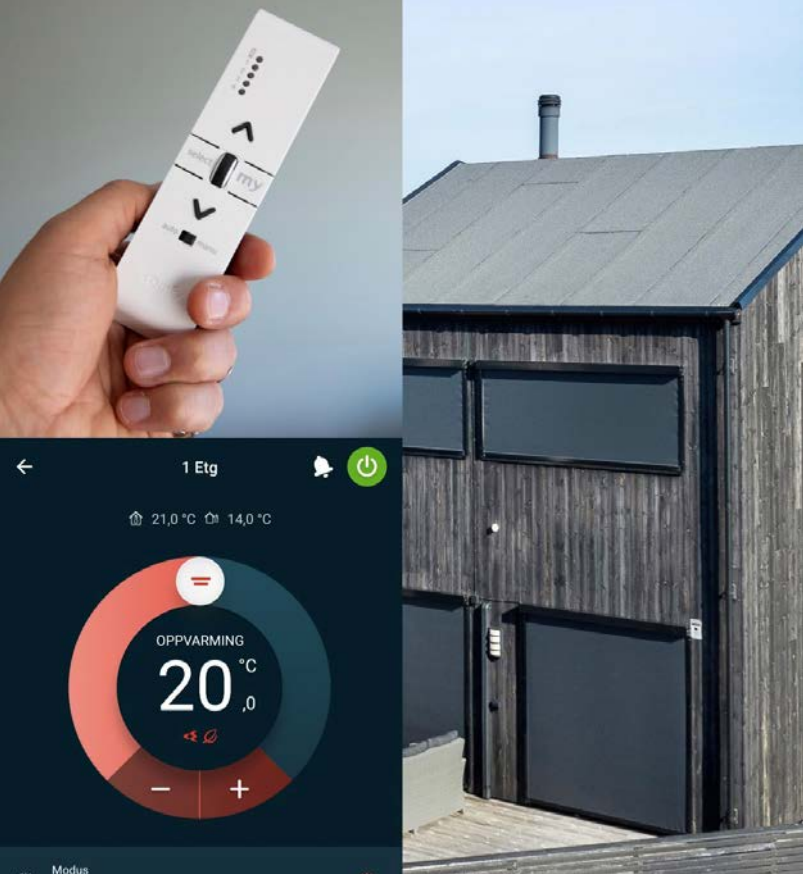
Utvendig solskjerming med solsensor og fjernkontroll. Styring av varme gjennom Daikin app.
