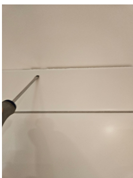
Bilde av silikolfuge mellom veggflis og tak/himling
