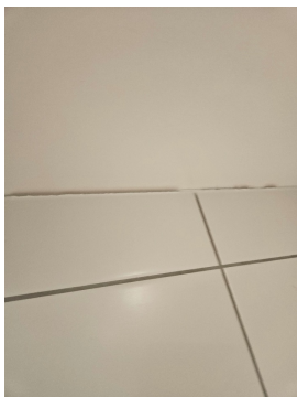
Bilde av silikonfuge mellom veggflis og tak/himling
