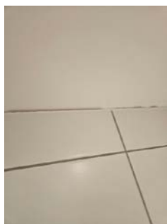
Bilde av silikonfuge mellom veggflis og tak/himling
