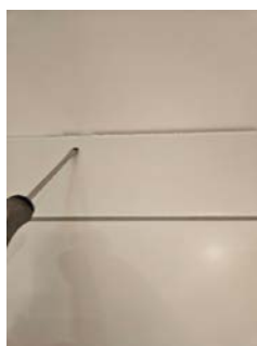
Bilde av silikonfuge mellom veggflis og tak/himling
