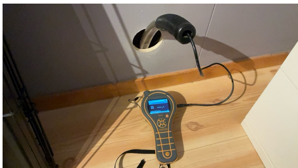
Ingen fuktutslag registret ved fuktmåling i vegg
