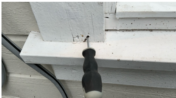
Råte i listverk og ingen klaring til beslag
