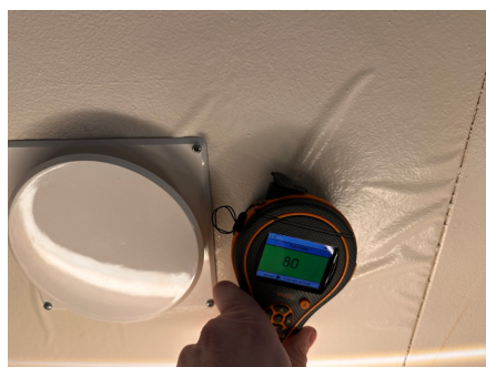
Ingen fuktindikasjoner ved fuktsøk i himling ved løs folie.
