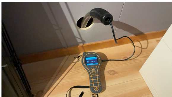
Ingen fuktutslag registret ved fuktmåling i vegg
