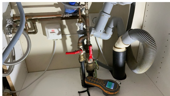
Ingen fuktighet registrert ved fuktsøk i skap under vask
