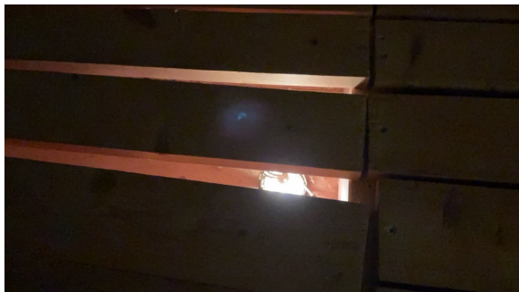
Løst gulv på bod, spotter under
