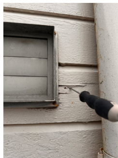
Råte ved ventil fra kjøkkenventilator
