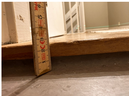
12-13mm høyde på membran under dørterskel
