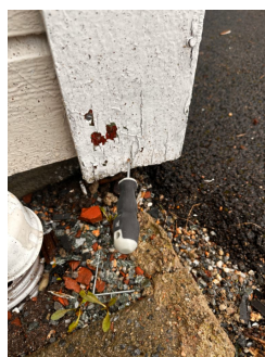
Råte ved ventil fra kjøkkenventilator
