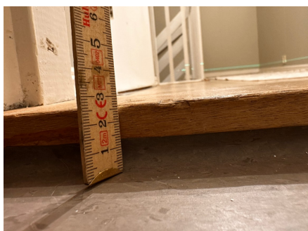
12-13mm høyde på membran under dørteskel
