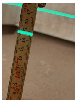
12-13mm høyde på membran under dørteskel
