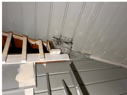
Overflater som ikke er ferdige i bod
