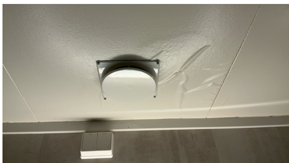
Løs folie på takplaten rundt ventil
