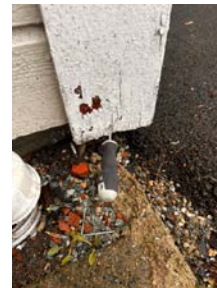
Råte ved ventil fra kjøkkenventilator
