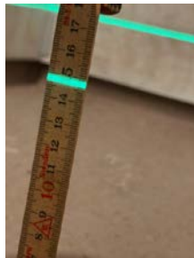
12-13mm høyde på membran under dørterskel
