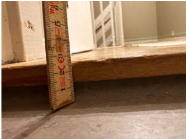
12-13mm høyde på membran under dørterskel
