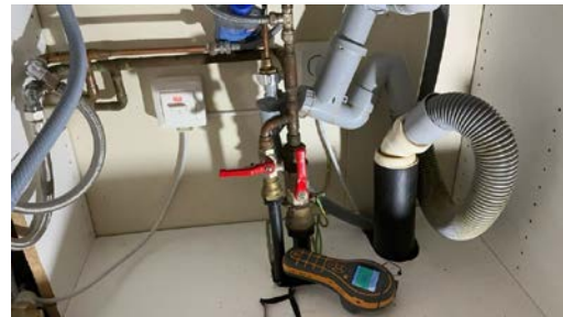
Ingen fuktighet registrert ved fuktsøk i skap under vask
