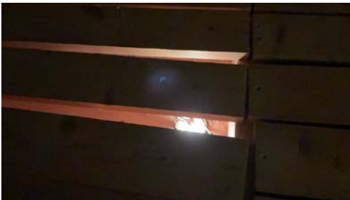
Løst gulv på bod, spotter under
