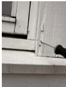
Råte i listverk og ingen klaring til beslag
