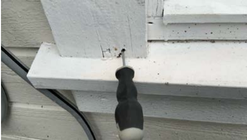
Råte i listverk og ingen klaring til beslag
