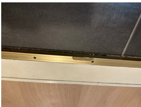
Overgang mot dørterskel.
