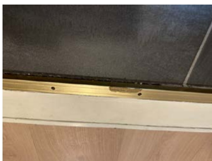
Overgang mot dørterskel.
