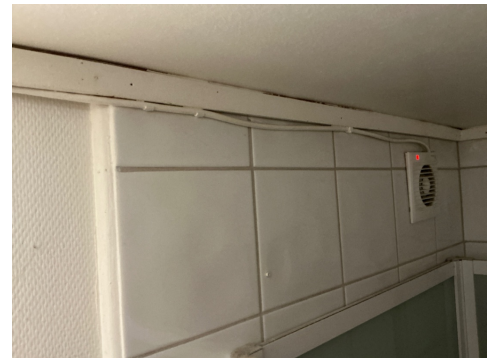
Ledningen fremstår stedvis ufagmessig.
