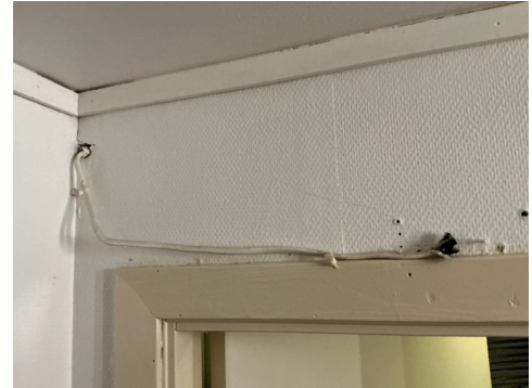
Ledningen fremstår stedvis ufagmessig.
