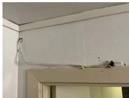
Ledningen fremstår stedvis ufagmessig.
