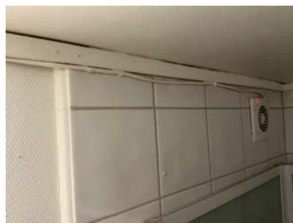
Ledningen fremstår stedvis ufagmessig.
