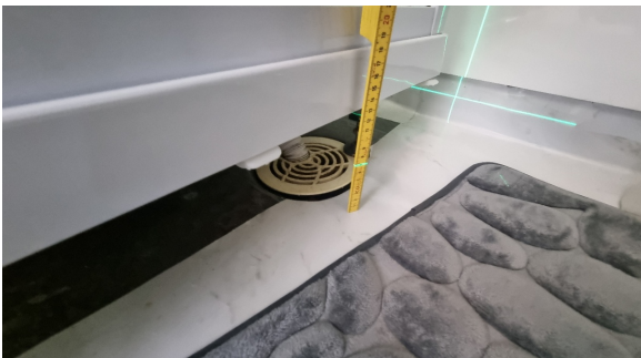
Gulvet har tilfredsstillende fall til sluk
