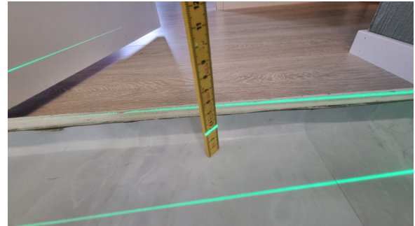
Kontroll av fall.
