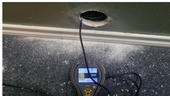
Det ble fuktmålt ved befarings, ingen forhøyde fuktverdier ble registrert i denne delen av konstruksjonen.
