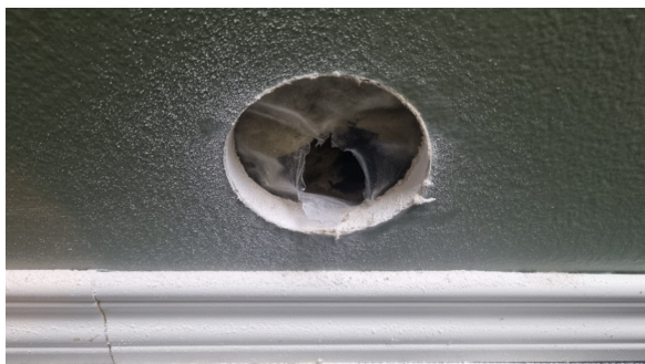
Det er benyttet dampspærre på innsiden av vegg under terreng.
