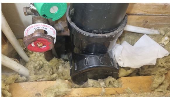
Avløpsrør av plast
