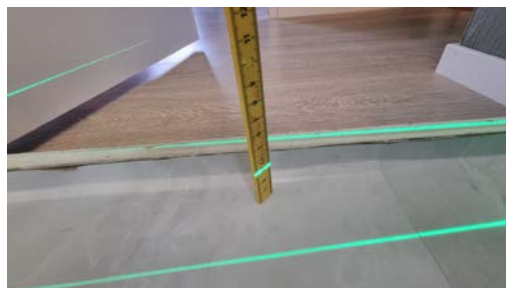
Kontroll av fall.
