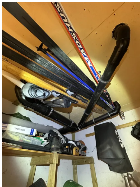
Viser avløpsrør av plast.
