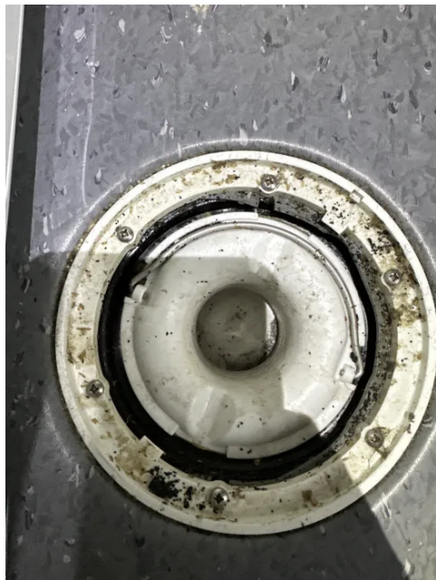
Viser sluk i gulv.
