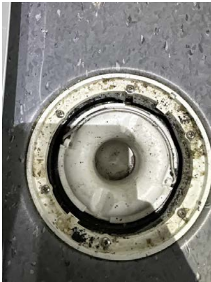
Viser sluk i gulv.
