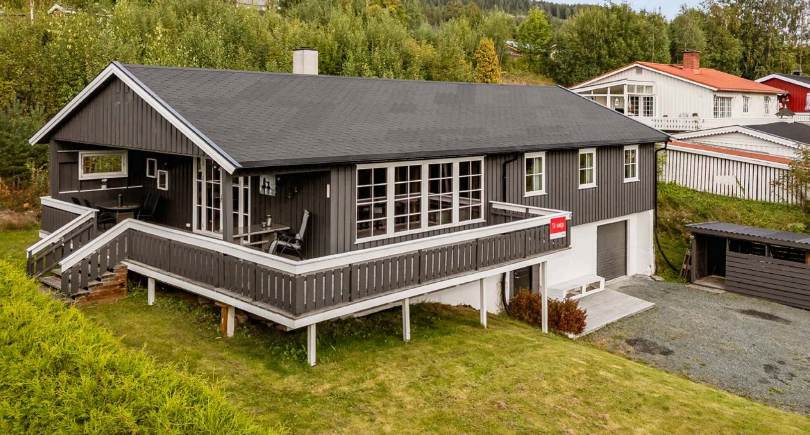
Boligen er velholdt, og har gjennomgått omfattende oppussing i nyere tid. Taket ble byttet i 2020
