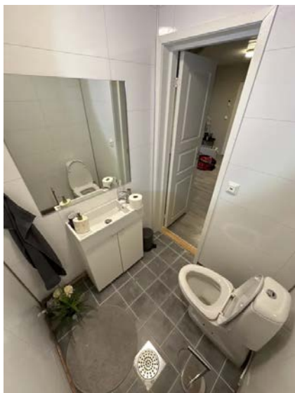
Viser toalettrom i sokkeletasjen.
