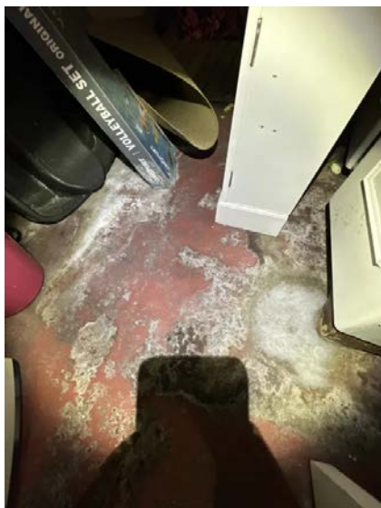
Det registreres mineralutslag (salt/kalkutsalg) i overflater som er et symptom på fuktvandring gjennom kjellergulv.
