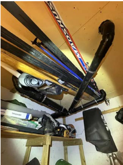
Viser avløpsrør av plast.
