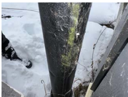
Det ble registrert buling/skade i nedløpsrør som er et symptom på frostspreng.
