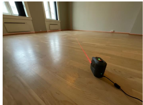
Nivellering stue, ingen avvik registrert
