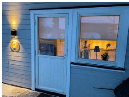
Terrassedør og kjøkkenvindu
