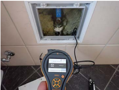
Årstall: 2023 Kilde: Andre opplysninger: Utført av takstmann på besiktigelsesdagen.
