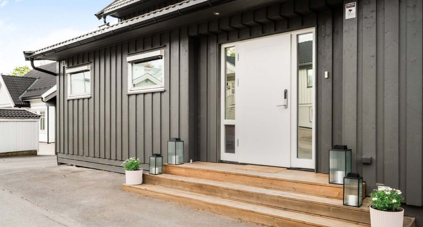
Delvis overbygd inngangsparti med trapp og downlights.
