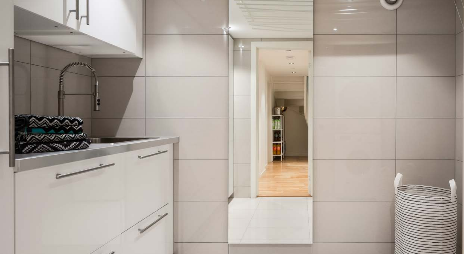
Eget vaskerom i kjeller med flislagte gulv og vegger. I gulvet er det varmekabler.
