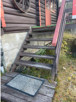
Oppsprukket og slitasje i overflater
