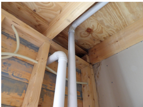
Eldre fuktmerker i tak utvendig bod.
