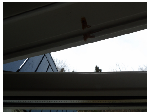
Skade på karm til altandør.
