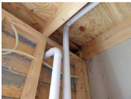
Eldre fuktmerker i tak utvendig bod.
