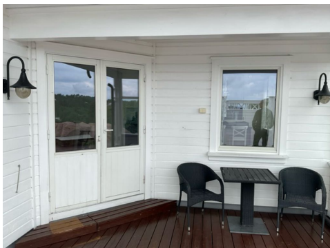
To fløy balkongdør ut fra stue.
