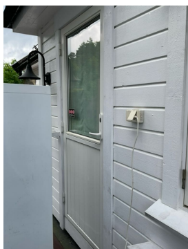
Balkongdør fra vindfang til vaskerom.
