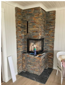
Peisnnsats kledd med forblendingsskifer i stue.
